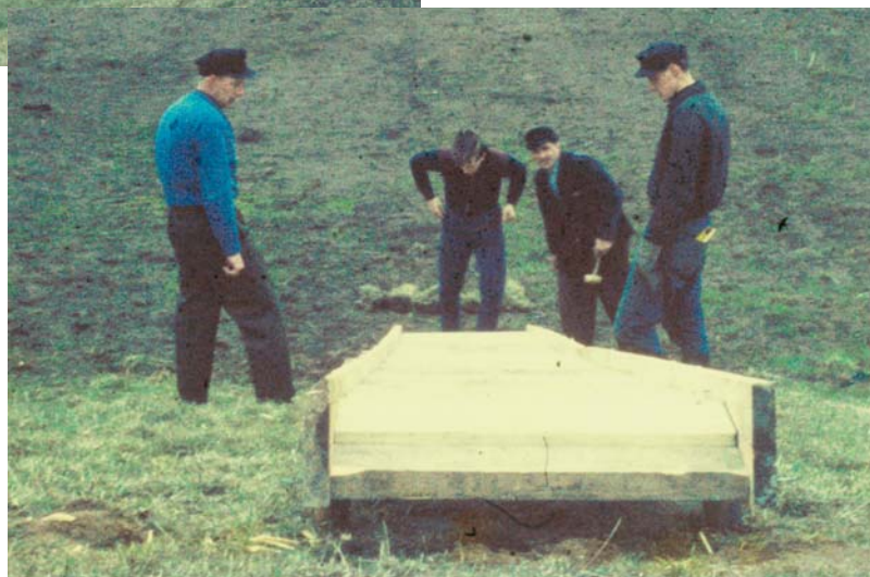
Die erste hölzerne Deichtreppe wird angelegt
