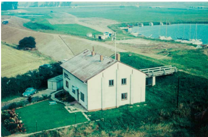
Auf Bremer Seite wird noch am Deich gearbeitet
