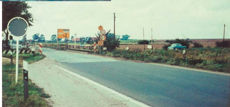
Die Brücke über den Leeste-Brinkumer- Zuleitungskanal
