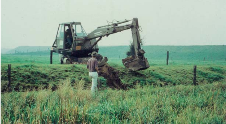
1963: Die Trasse für die Wasserleitung wird ausgehoben
