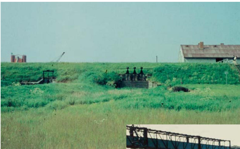
Das Deichsiel neben dem Bootshaus wird nicht mehr benötigt, da der Leeste- Brinkum-Zuleitungskanal zugeschüttet wurde.
