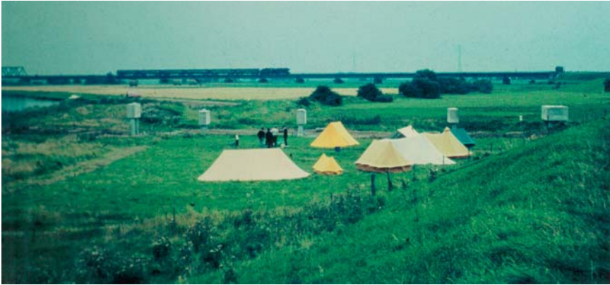
Die Firma Winkler errichtet ihre Förderbandanlage
