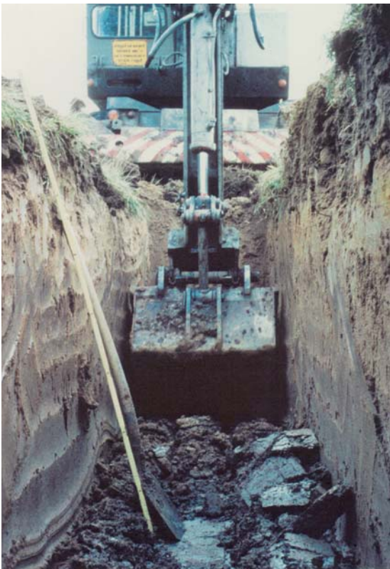
Per Bagger wurde der 400 m lange Graben für die Wasserleitung durch den schweren Lehmboden ausgehoben ...
